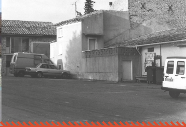
ENTRÉE DE LA HALLE ACTUELLE / MAISON RAMEL
