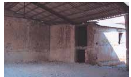
HANGAR ROULLET AVANT TRAVAUX
