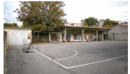
LA FAÇADE ET LE PRÉAU AVANT TRAVAUX
