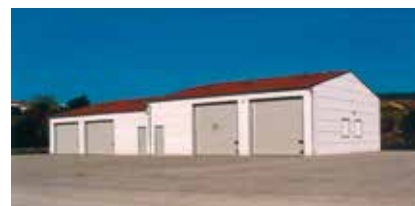
LOCAUX DES SERVICES TECHNIQUES
