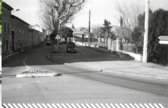
ENTRÉE EST ACTUELLE ET AVANT TRAVAUX
